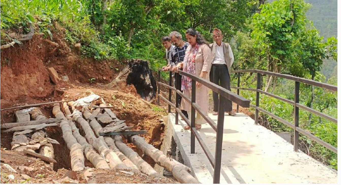
बिदुर-१२ चारघरे नयाँ चौतारादेखि भदुवार टोल जोड्ने बाटोमा जोखिमयुक्त काठको टेकोलाई विस्थापन गरि ढलानको पुलको अनुगमनमा उपप्रमुख प्रभा बोगटी
